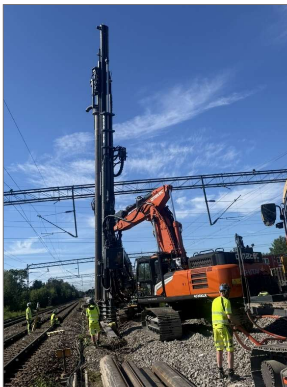
Figur 5-4 Borrigg för sänkhammarbörning för installation av pålvägg med ringborkkrona. Foto: Olle Kvick
