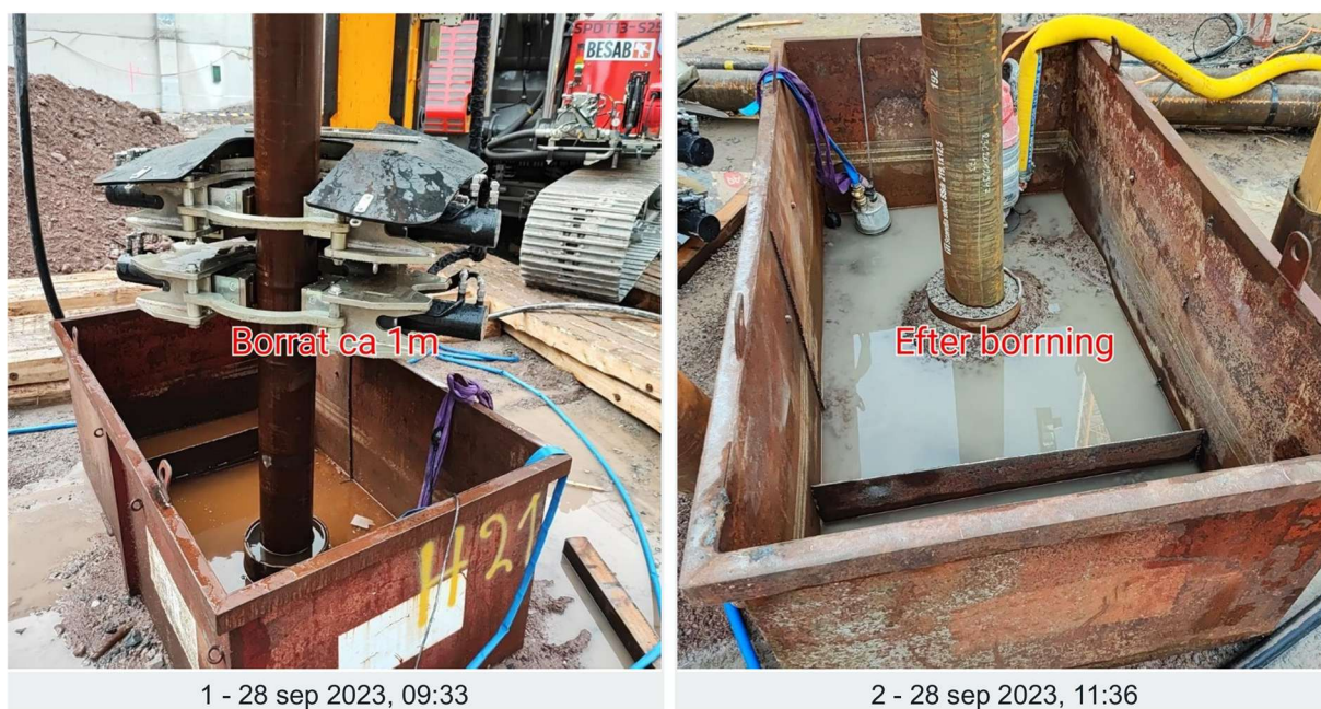
Figur 8-2 Uppsamlingskärl från provborring som visar exempel på ett uppsamlingskärl. Bilderna visar före och efter borring utförd borring som en del i av dokumentation under provpållning. Foto: Besab.
