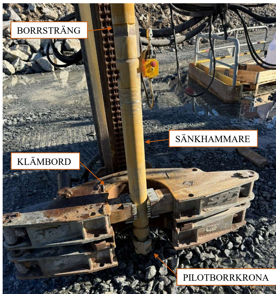
Figur 5-3 Sänkhammarutrustning utan utanpåliggande rörpåle. Foto: Olle Kvick
