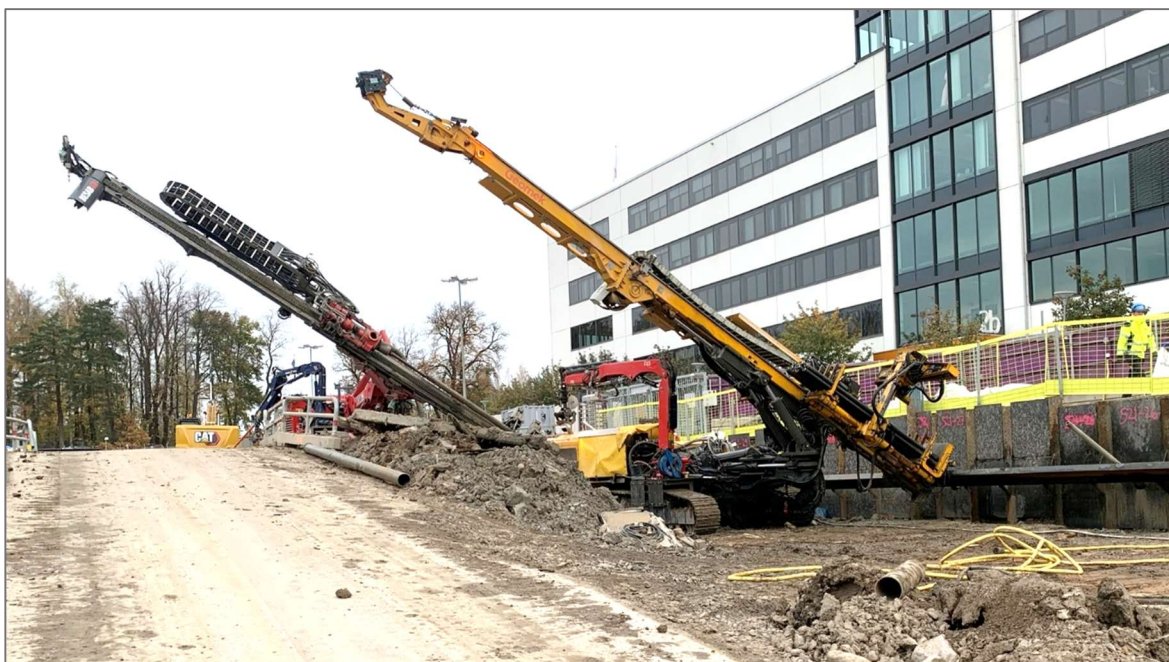
Figur 5-2 Topphammarborrning av självborrande stag. Foto: Oscar Ögren
